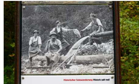
Eine Informationstafel auf dem historischen Solewanderweg zeigt mehrere Männer bei Wartungsarbeiten an der Soleleitung.
