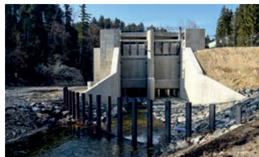
Das neue, 14 Meter hohe Sperrbauwerk am Tobelbach dient dem Hochwasserschutz.
